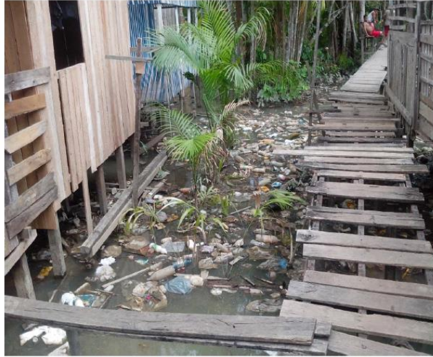
Figura 49: Acúmulo de resíduos sólidos nos corpos hídricos do Bairro Paracuri.
