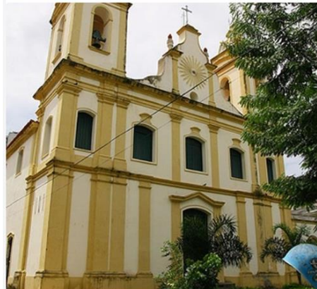
Figura 26: Imagem da Igreja da Nossa Senhora do Rosário dos Homens Pretos.
