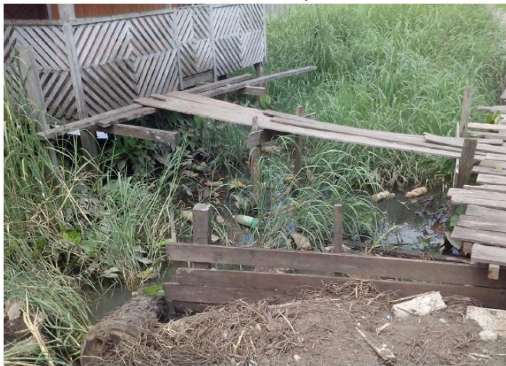
Figura 50: Acúmulo de resíduos sólidos nos corpos hídricos do Bairro Águas Negras.
